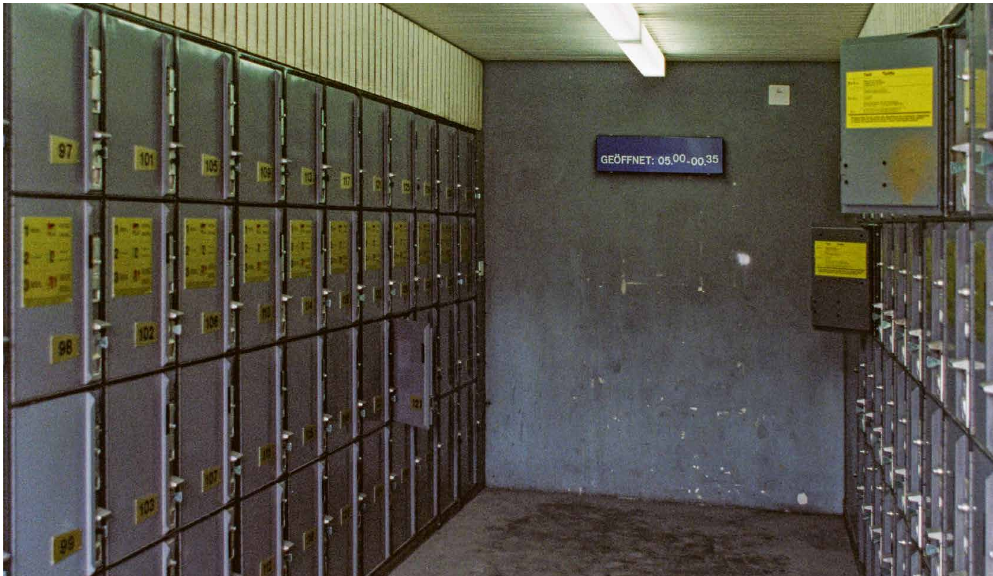
Schliessflächen an Gleis 1 (Foto 1986. Werner Huber)
