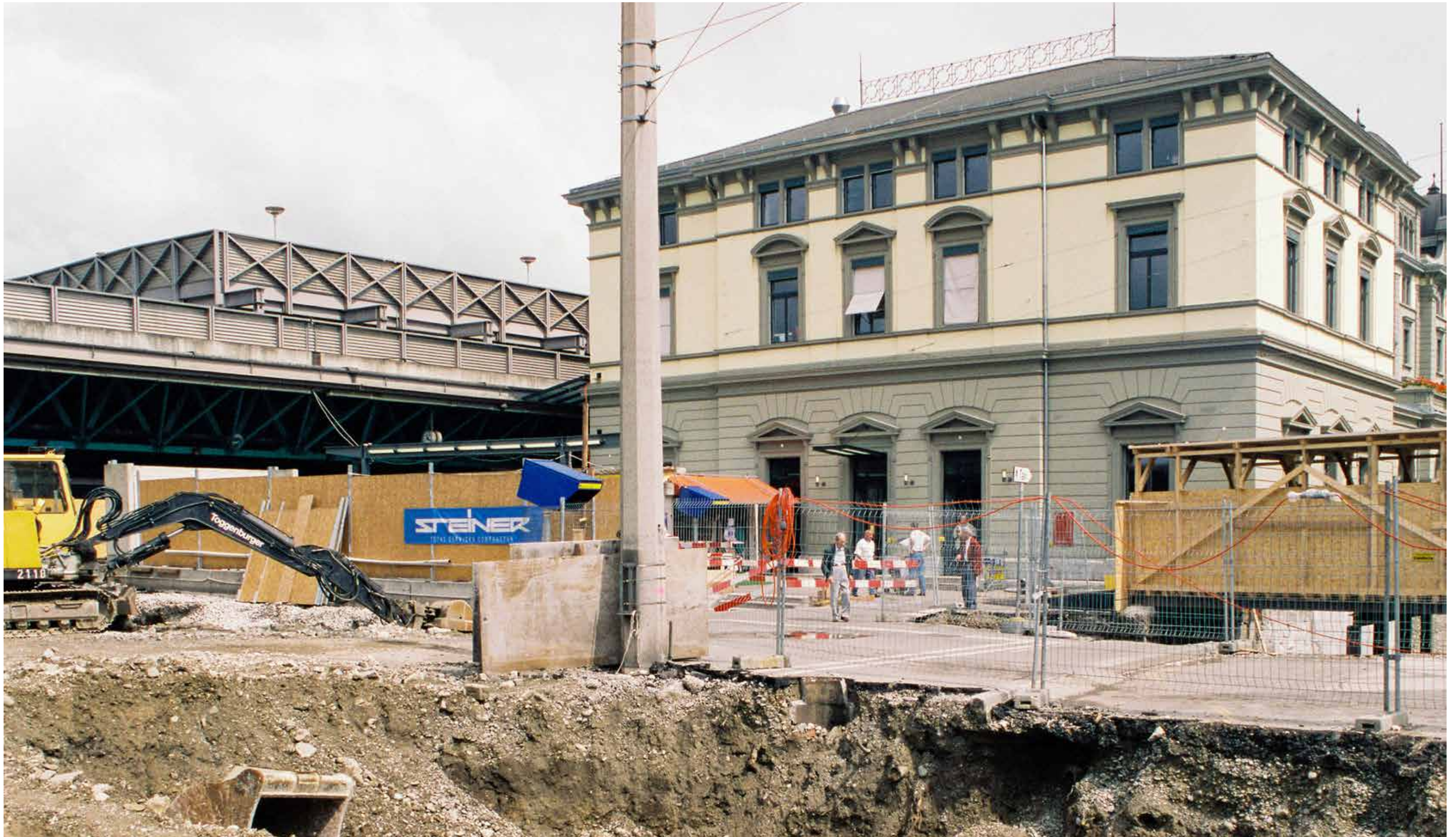
Bauarbeiten für das «Stadttor» (Foto 1999. Werner Huber)
