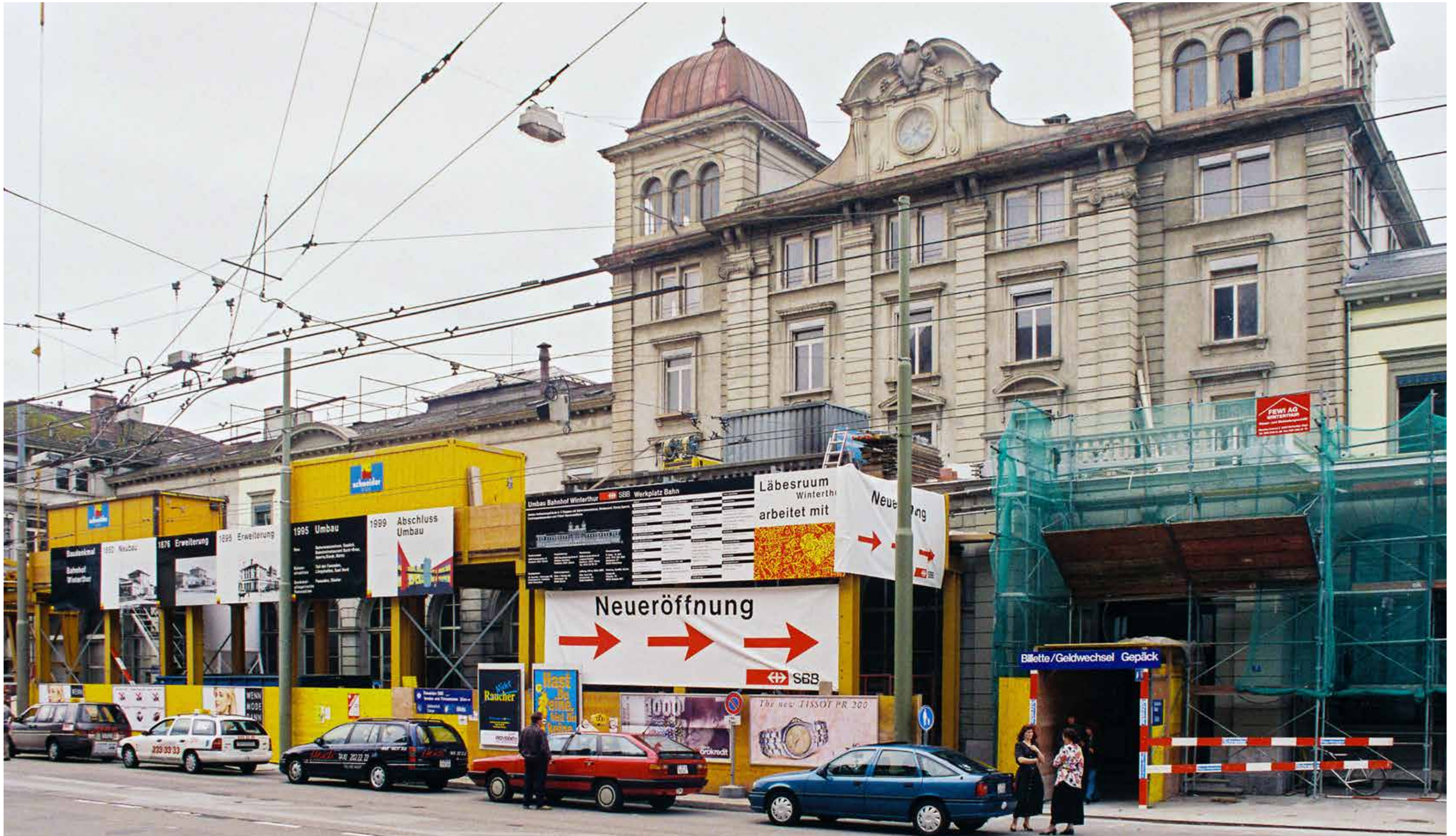
Das Aufnahmegebäude wird saniert und umgebaut (Foto 1996. Werner Huber)
