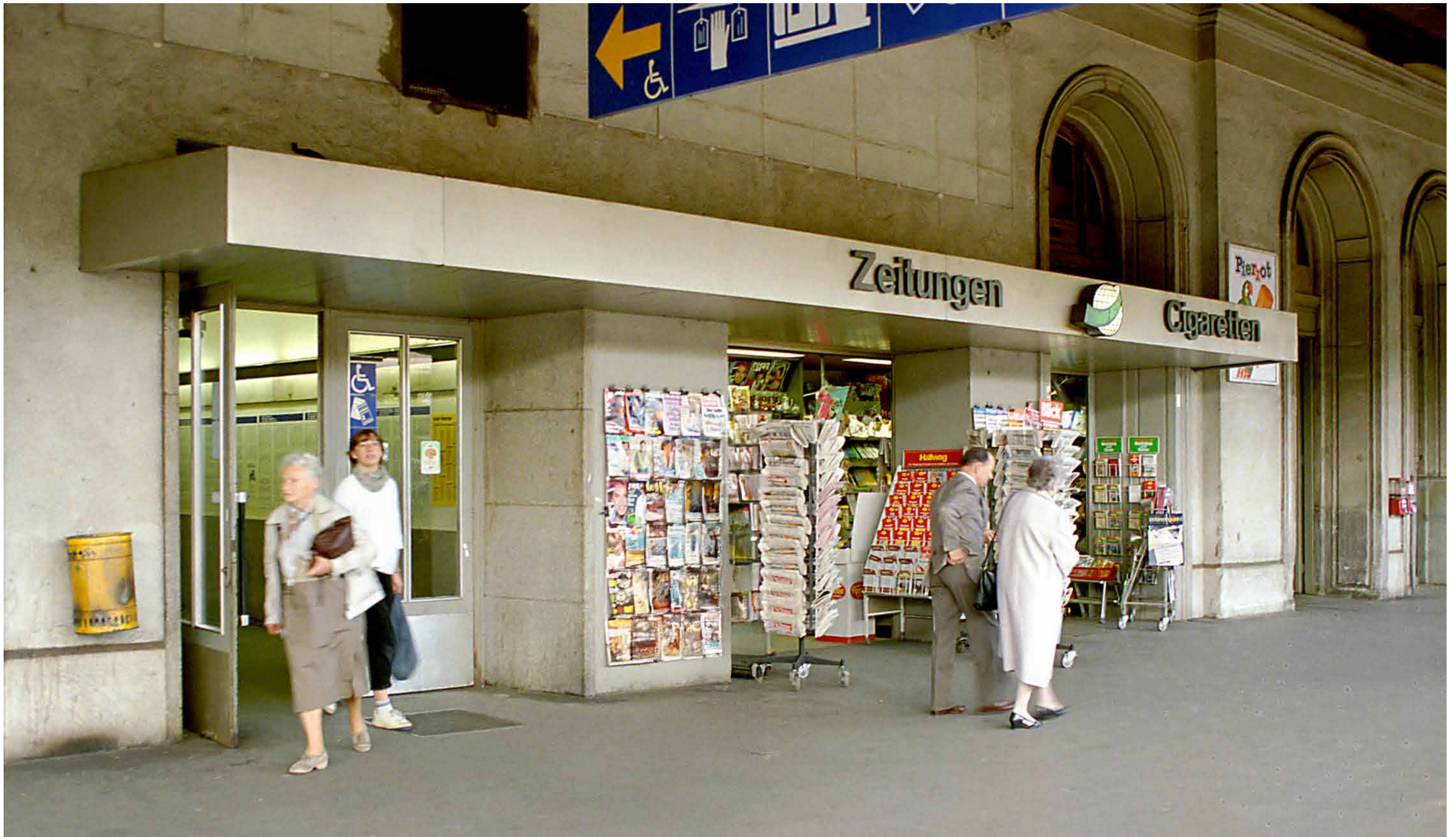
Durchgang und Kiosk an Gleis 1 (Foto 1985. Werner Huber)
